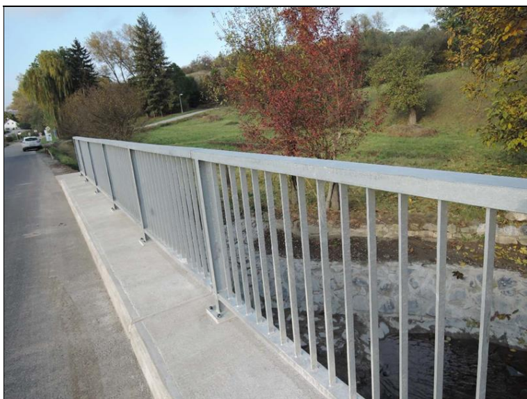
Pohled na zábradlí a římsy s povrchem opatřeným striáží.
