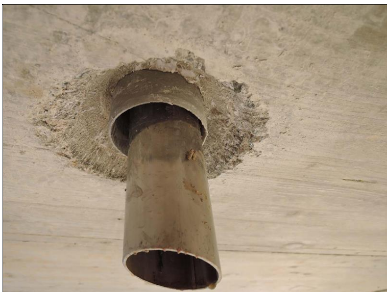
Pohled na odvodňovač izolace.
