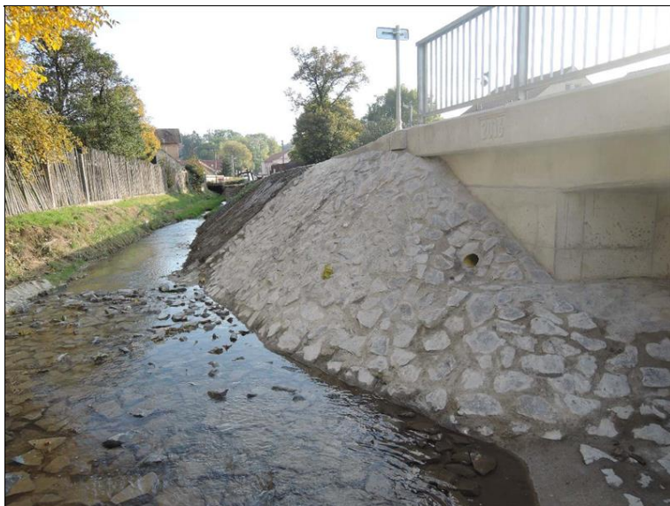
Pohled na opevnění kuželů zemního tělesa vpravo u OP1.
