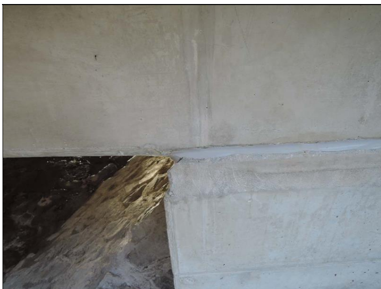
Pohled na spáru na styku spodní stavba - křídlo rámu.
