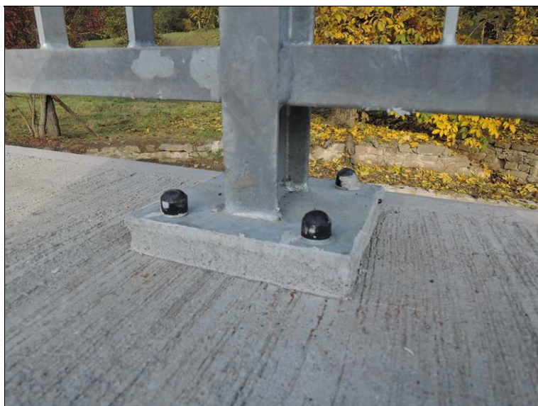
Pohled na ukotvení zábradlí.
