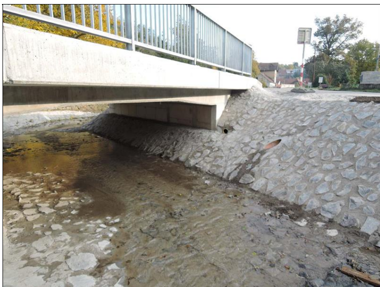
Pohled na opevnění na vtoku, prostup drenáže a dešťové kanalizace.
