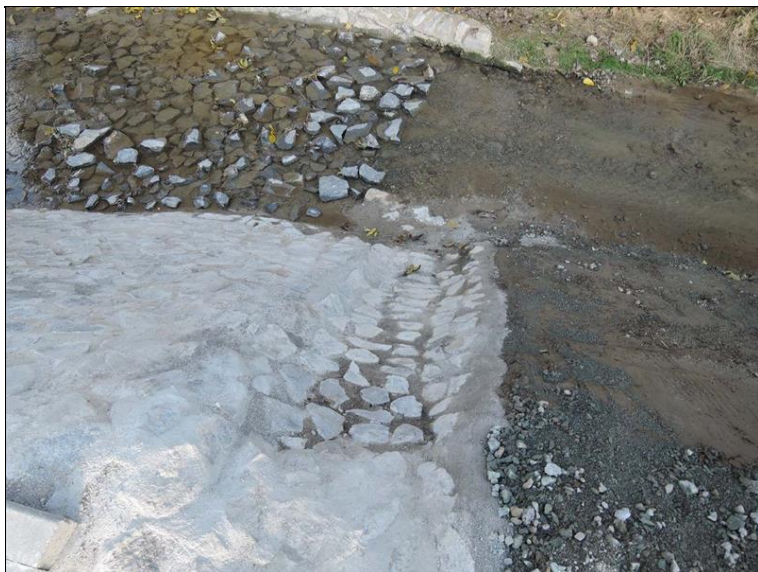
Pohled na kamenný skluz vpravo před mostem.
